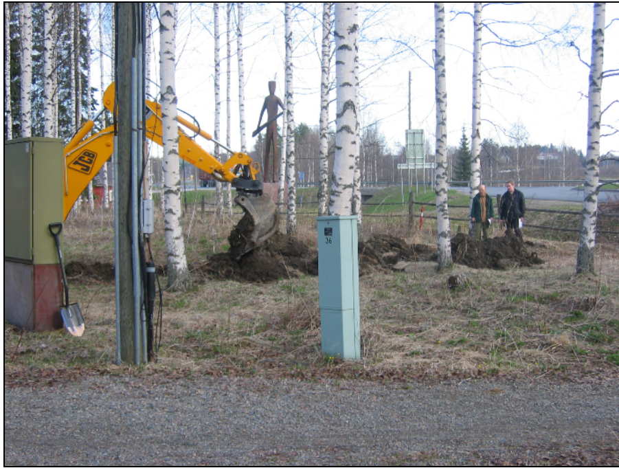
Koeojaa 1 kaivetaan. Taustalla Iisalmi – Oulu-maantie.
